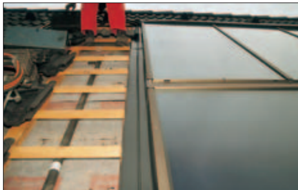
Abb. 6.3.2 Indachkollektoreindeckung; Quelle: (3)
