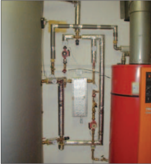
Abb. 5.18 Pufferentladekreis; Quelle: ASiC
