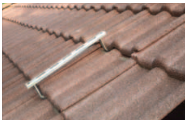
Abb. 6.4.2 Montage einer Halterung; Quelle: (3)
