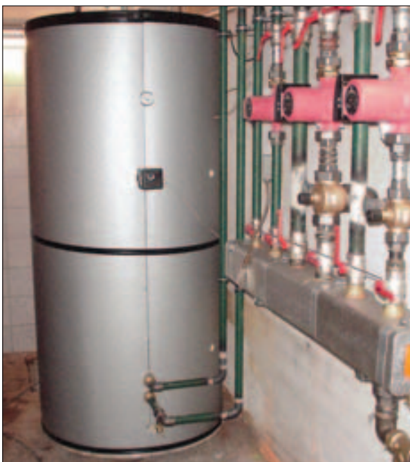
Abb. 2.11 Brauchwasserspeicher; Quelle: (6)
