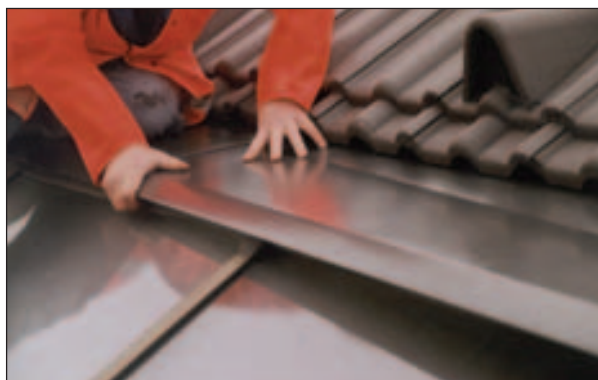
Abb. 6.3.4 Indachkollektoreindeckung; Quelle: (3)
