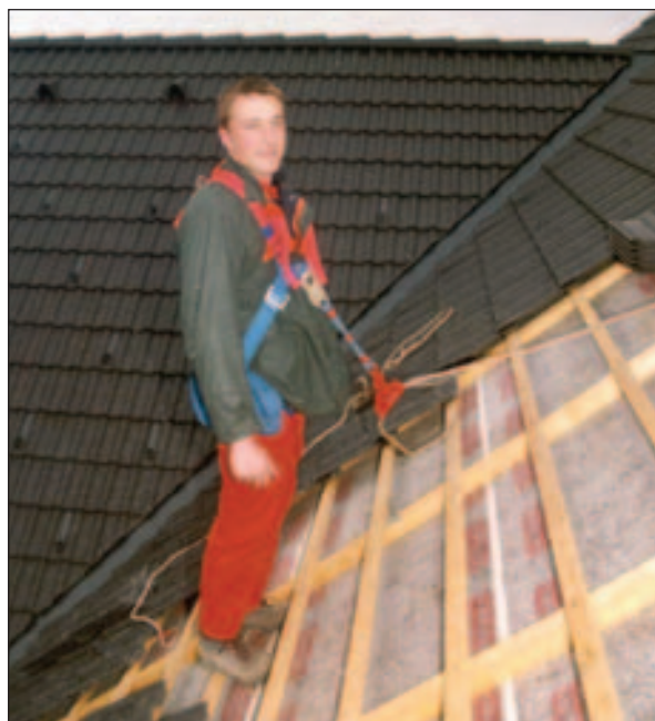
Abb. 6.5 Absicherung bei einer Steildachmontage; Quelle: (3)
