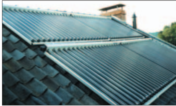
Abb. 2.3 Vakuumröhrenkollektor; Quelle: (3)
