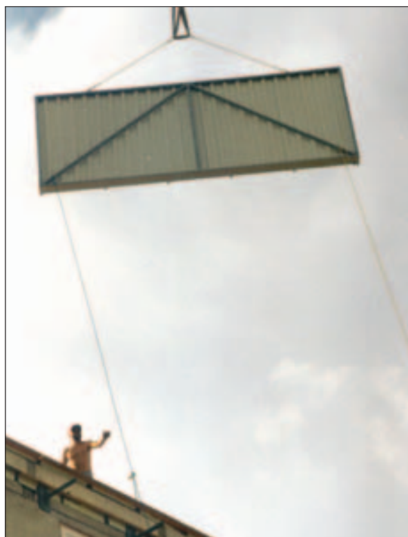
Abb. 6.9.1 Abfolge einer Kranmontage; Quelle: (12)
