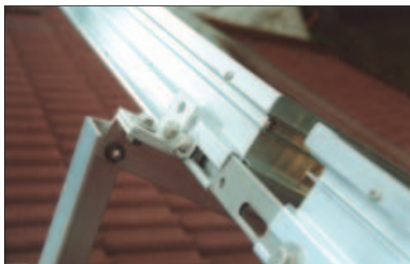
Abb. 6.4.4 Aufdachmontage mit Aufständerung; Quelle: (3)
