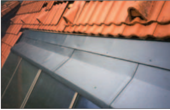
Abb. 6.3.5 Eindeckung eines Indachkollektors; Quelle: (3)
