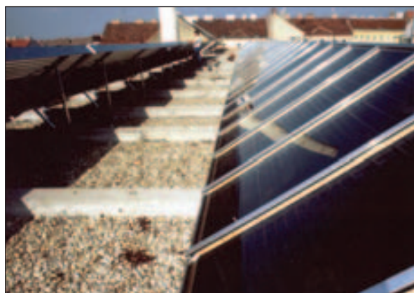
Abb. 6.6.1 Aufständern des Kollektorfeldes am Flachdach; Quelle: (4)
