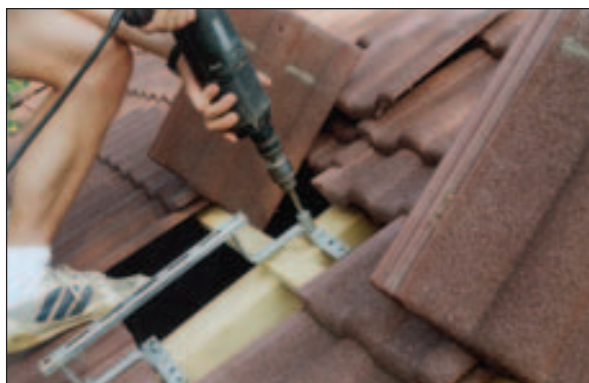
Abb. 6.4.1 Montage einer Halterung; Quelle: (3)
