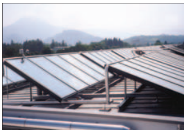
Abb. 6.6.2 Aufständern des Kollektorfeldes am Flachdach; Quelle: ASIC
