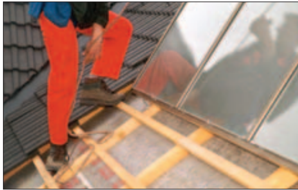
Abb. 6.3.1 Indachkollektoreindeckung; Quelle: (3)
