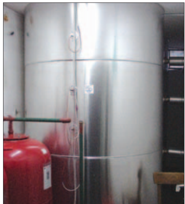
Abb. 2.12 Pufferspeicher; Quelle: (6)
