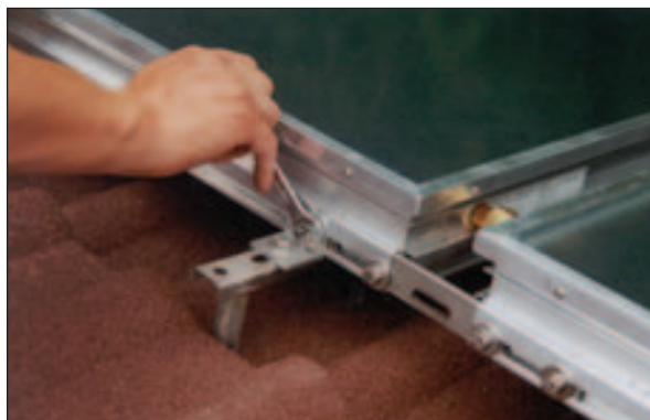
Abb. 6.4.3 Befestigung der Kollektoren; Quelle: (3)
