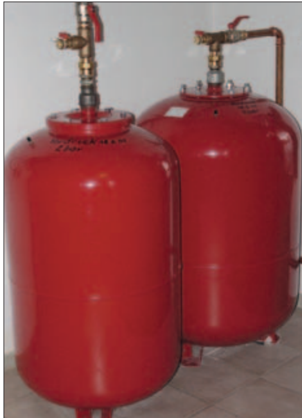
Abb. 2.19 Ausdehnungsgefäß; Quelle: ASIc
