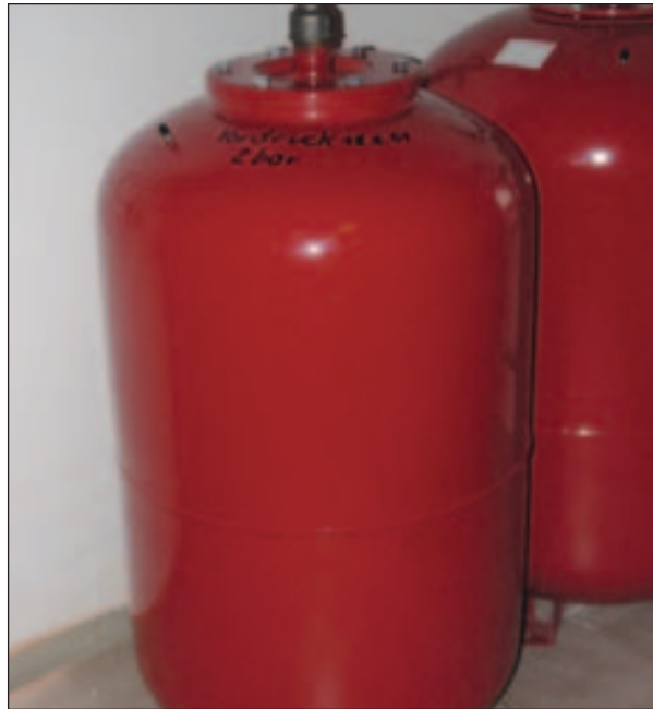
Abb. 5.17 Membranausdehnungsgefäß; Quelle: ASiC
