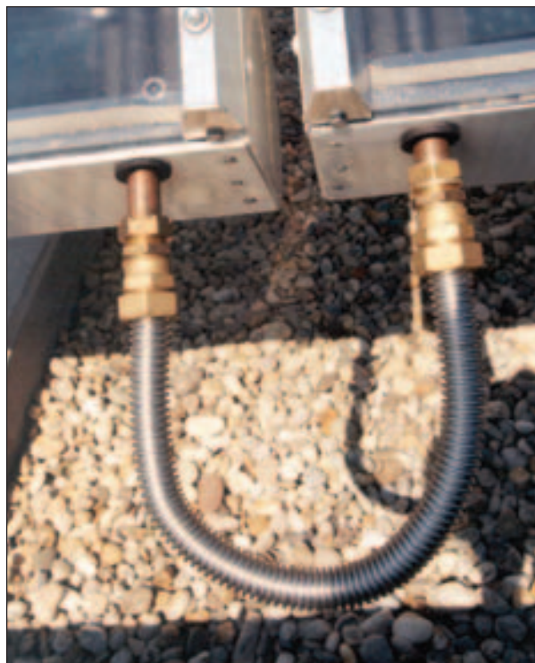
Abb. 6.13 Wellrohrverbindungsleitung; Quelle: (12)
