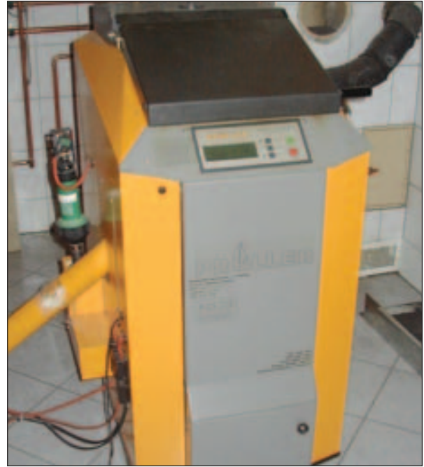
Abb. 2.16 Nachheizkessel; Quelle: (1)
