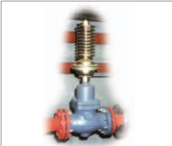
Abb. 5.16 Hauptsicherheitsventil einer Großanlage; Quelle: ASiC
