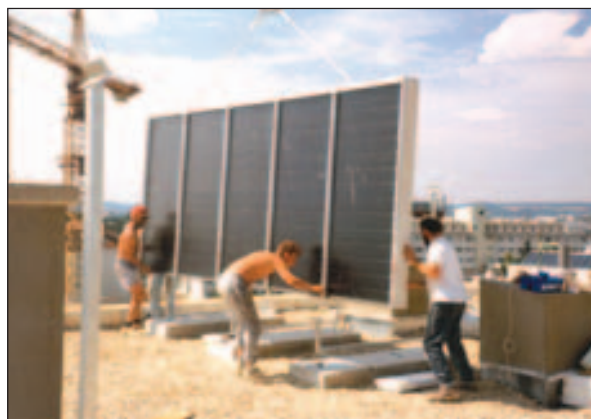
Abb. 6.9.2 Abfolge einer Kranmontage; Quelle: (12)
