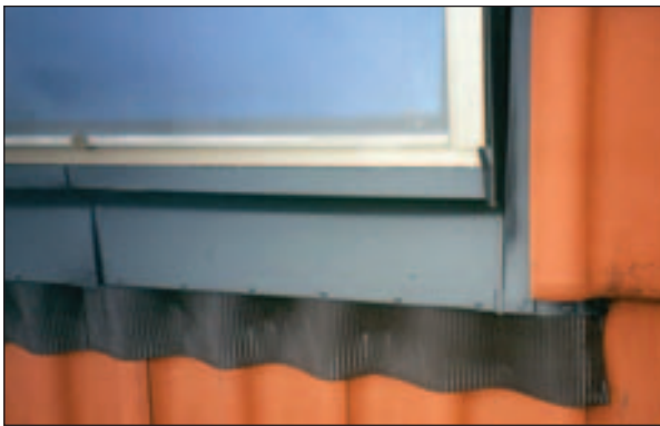
Abb. 6.3.6 Eindeckung eines Indachkollektors; Quelle: (3)
