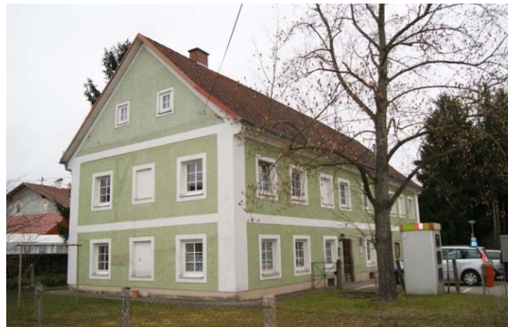
Objekt 5: Kirchengasse 1 – Historisches Gebäude
